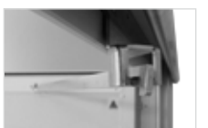
Aretace křidel zamezí zavření křidel vrat při průjezdu
